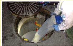
水道管の末端部に停滞した水道水を計画的に排出します
