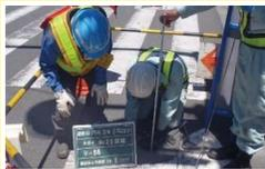
消火栓・制水弁等の機能調査を行って劣化診断を行います
