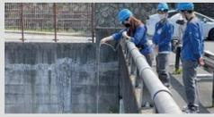
水道水の原料となる河川水や浄水処理の工程ごとに採水します。
