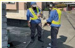
地上に現れない地下漏水を調査機器を使い探して補修します。
