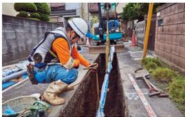
工事監督業務の主な内容は、下水道、ガス、電気など他企業工事との工程調整や沿道住民の方々に對し工事の説明をした後、①設計図書に従って工事が進められているか(品質管理)、②安全に工事が進められているか(安全管理)、③決められた期間内に工事が完了するか(工程管理)をパトロールしながら確認することです。なお、現場状況によっては、工事内容を一部変更することがあります。
