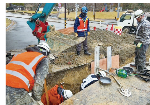
既設管漏水箇所の復旧活動(石川県輪島市)
