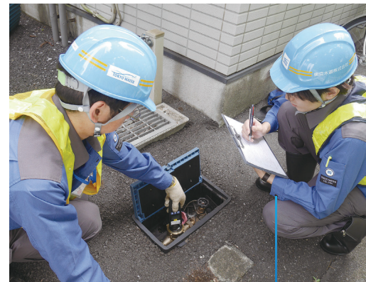
漏水調査・漏水防止対策
