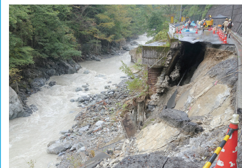
道路崩壊に伴う水道管復旧活動(東京都奥多摩町日原街道)
