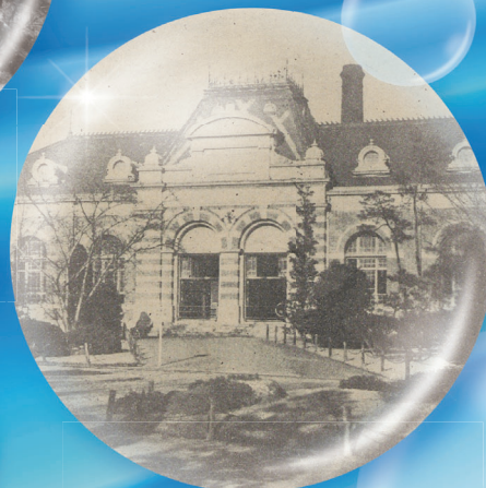
【淀橋浄水場】機関室／明治後期頃 (東京都水道歴史館所蔵)
