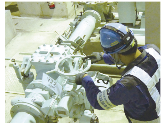
管路施設の調査・診断
