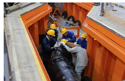
▲配水管（大口徑）接合研修
