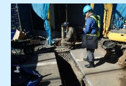
管路工事の監督
